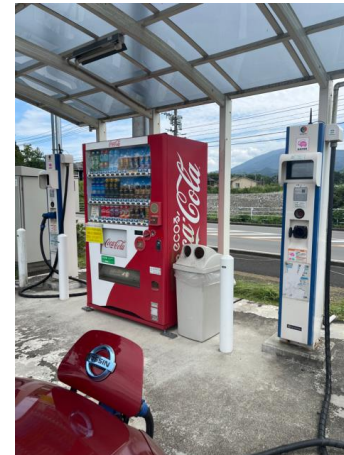
EV充電器の設置
